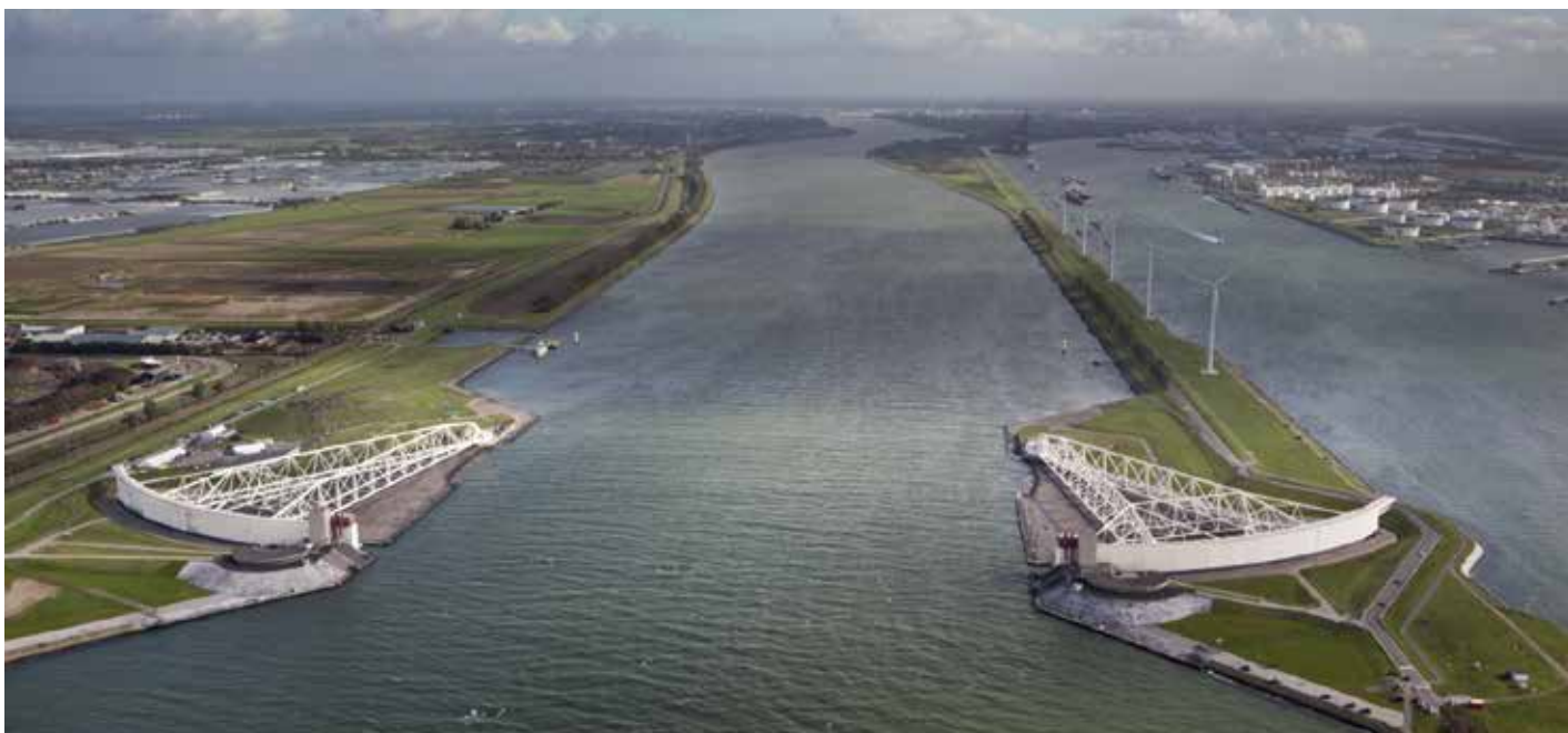
Windturbines benadrukken de 'lange lijnen' en vormen onderdeel van het havenlandschap. (foto: beeldbank Rijkswaterstaat).
