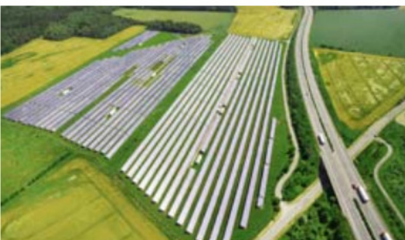
De transformatoren logisch plaatsen in het zonneveld...
